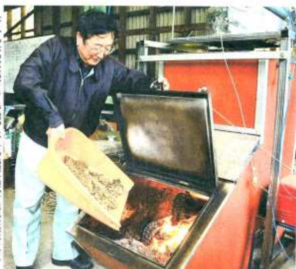
木くずや木の皮をボイラーで焼やし、その熱源を使って温風を発生させる
